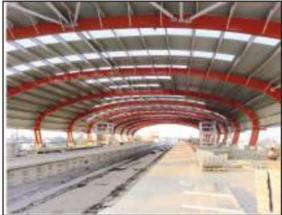
प्रॉयोरिटी कॉरिडोर (आईआईटी-मोतीशील) पर चल रहें हैं। कॉरिडोर-1 के बैलेंस सेक्शन यानी चुनौरीज से नौबस्ता तक चल रहे निर्माण कार्य के अलावा लगभग 8.60 किमी लंबे कॉरिडोर-2 (सीएसए-बर्ग 8) का निर्माण कार्य भी तेजी से बढ़ रहा है।
